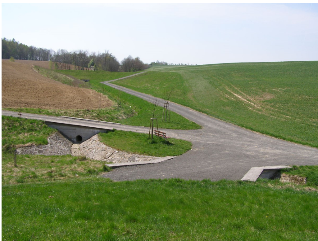
Pozemkové úpravy připravují pozemky pro realizační práce – ukázka zrekonstruované polní cesty s propustky v Darkovičích
