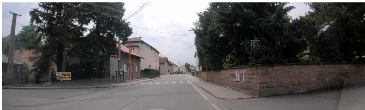
Obr. 11: Větvemi zakryté značení přechodu pro chodce a parkoviště
