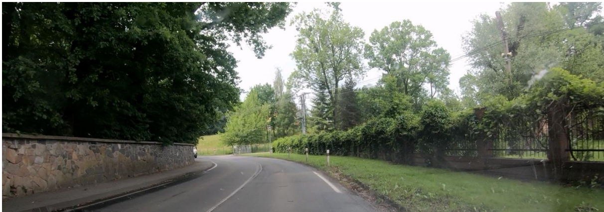
Obr. 4: Nerozšířená vozovka v místě nepřehledného oblouku malého poloměru
