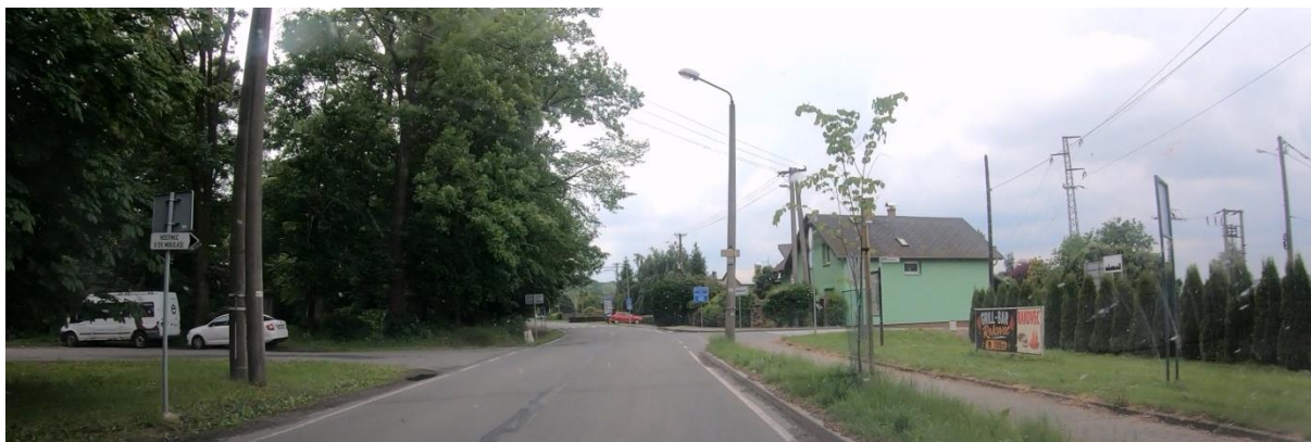
Obr. 9: Boční odsazení značky IZ4a snižuje její viditelnost pro řidiče
