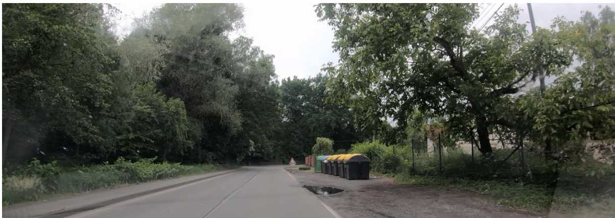
Obr. 6: Nezajištěný odtok vody z plochy vedle komunikace
