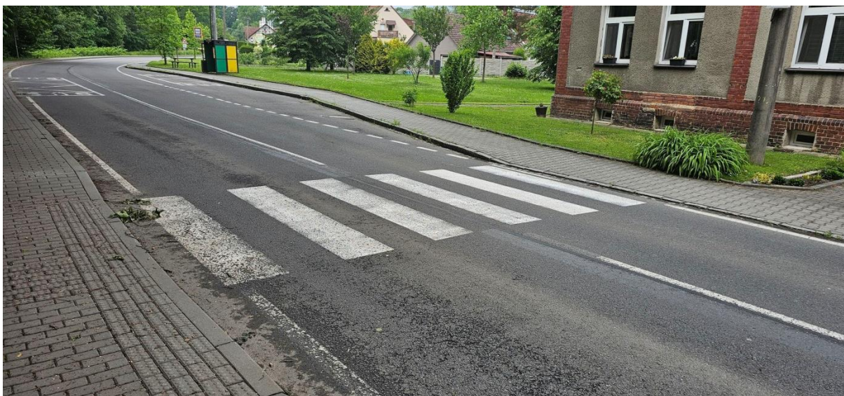
Obr. 13: Úplná absence varovných a signálních pásů (vpravo), nekонтastní provedení signálních a varovných pásů (vlevo)
